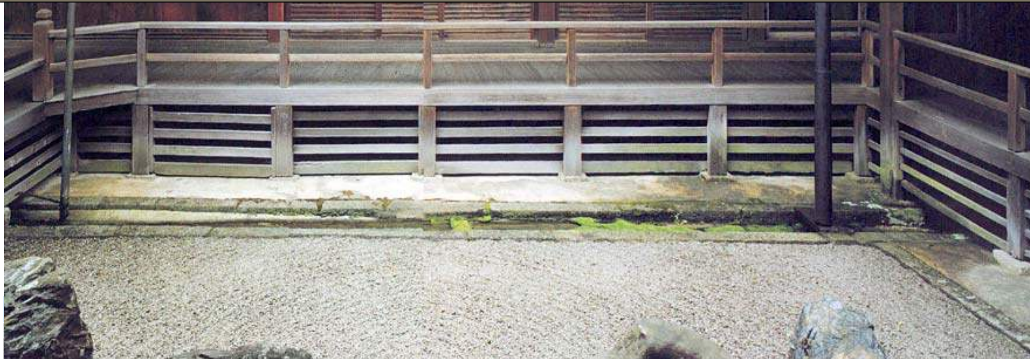
Houten dekken en treden boven halfondergrondse (parkeer)ruimten met uitzicht op een plein
